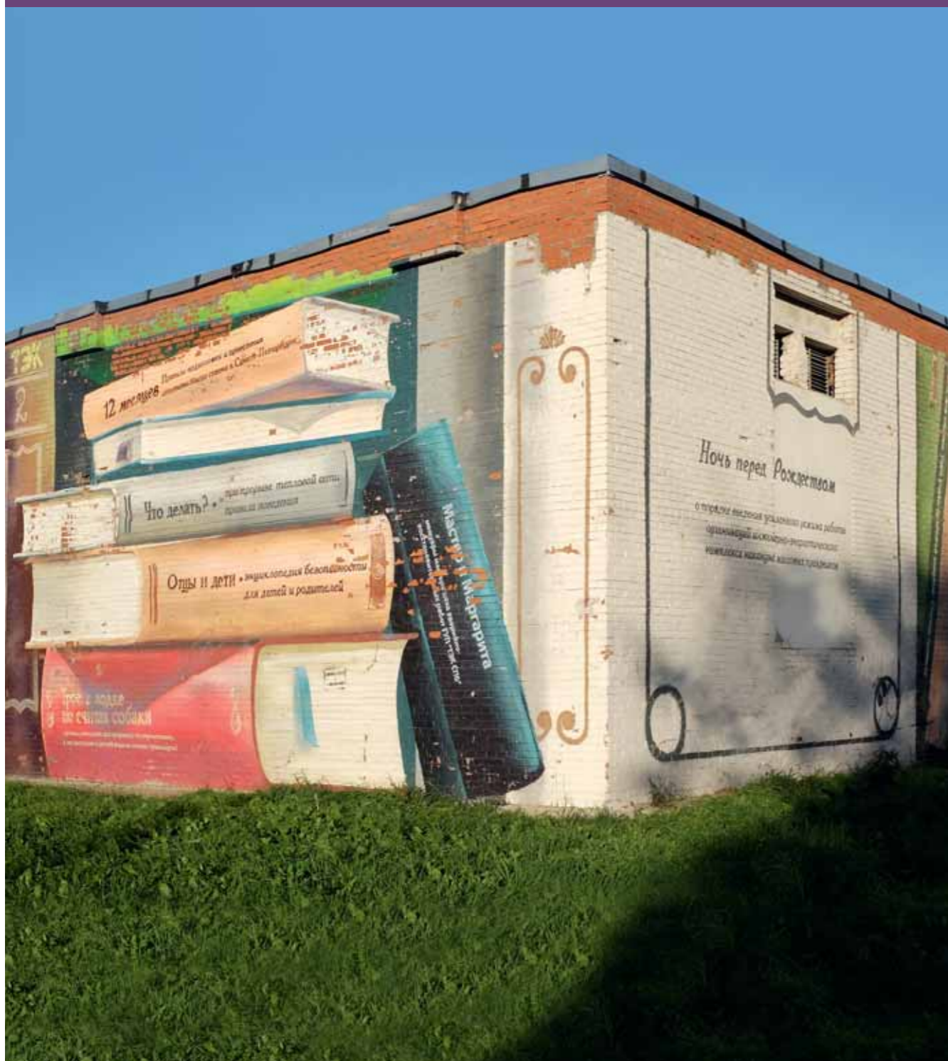
Трансформаторная подстанция на пересечении Российского и Товарищеского проспектов. Мастерская архитектурной графики «Арт-фасад».
