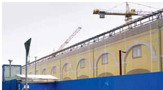
Сельдяной ряд Никольского рынка. (Щепяной пер., д. 7). Реставрационные работы. 10.02.2017.
